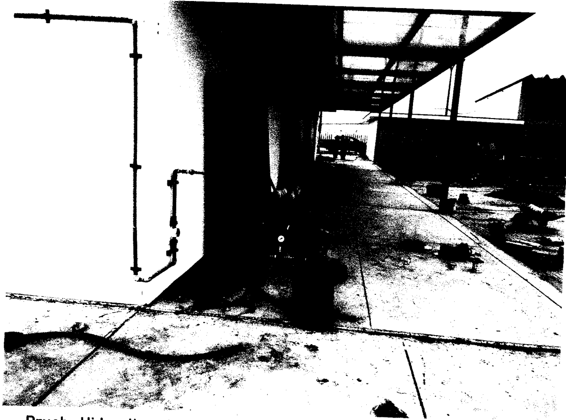
Prueba Hidraulica a las redes de agua potable y salada en sala de tareas previas.
