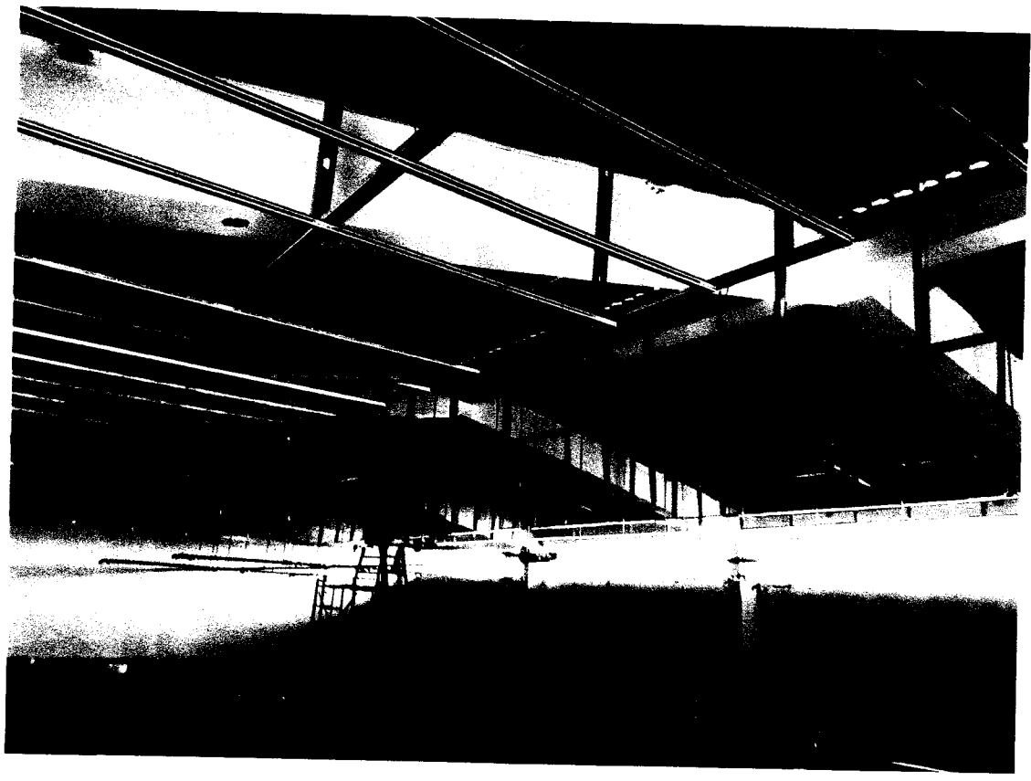
Colocacion de estructura de soporte para falso cielo raso de pvc.
